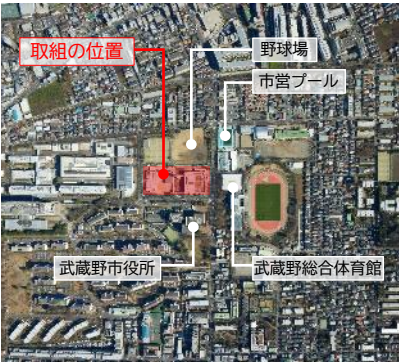
市街地に立地する清掃工場
