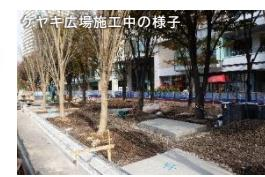
保水性舗装は、火山灰をリサイクルした高強度のレンガブロックを使用し機能と管理面の両立。貯留採石路盤自体を路盤層として使用し、水の吸い上げ機能向上を図った。
