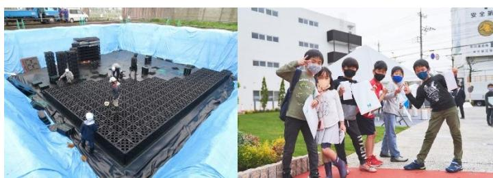
雨水流出抑制施設（アクリア工法）
