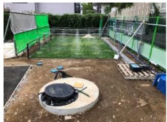
写真2: 火山砂利敷設、循環用貯留槽の設置
