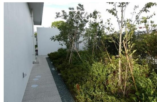
在来種主体の雑木の庭と緑地への雨水還元を考慮した雨水浸透側溝
