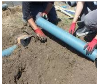
写真 通気透水管の敷設
