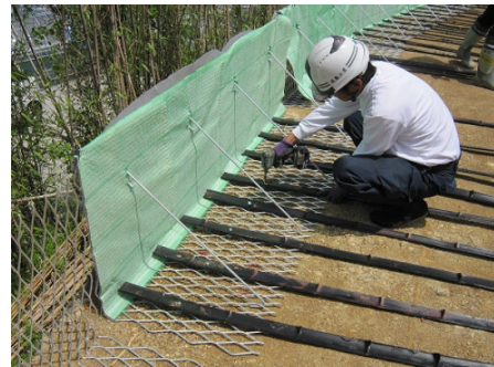
図 バンブーウォールの施工状況
