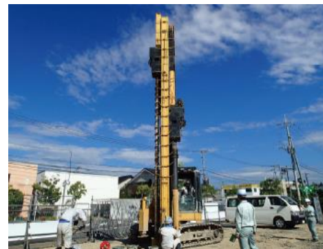
図 佐賀県佐賀市での施工事例
