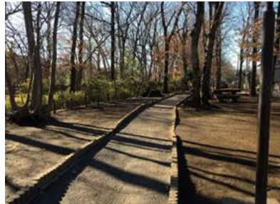
写真 浸透能が低下している公園の緑地
