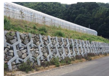
施工事例：山口県周防大島町 みかん畑農地整備工事
