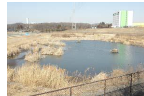
産業団地の敷地内の調整池の環境配慮としてビオトープを整備した。水鳥の生息地として利用されている。
