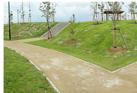
写真 ATTAC工法の施工された園路
