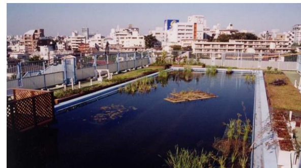
写真 既存の屋上のプールをコンテナを使用したビオトープに改修、非常時は防火用水等に利用
