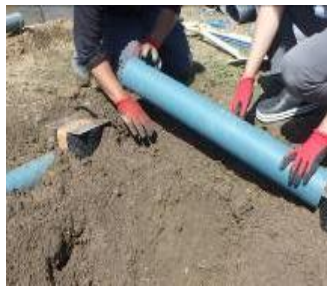
写真 通気透水管の敷設
