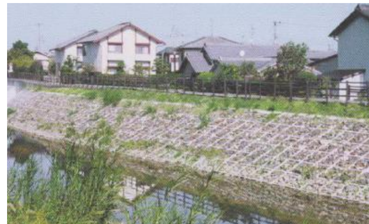
写真 施工イメージ
