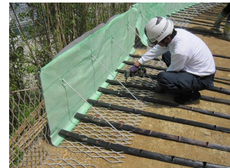
図 バンブーウォールの施工状況
