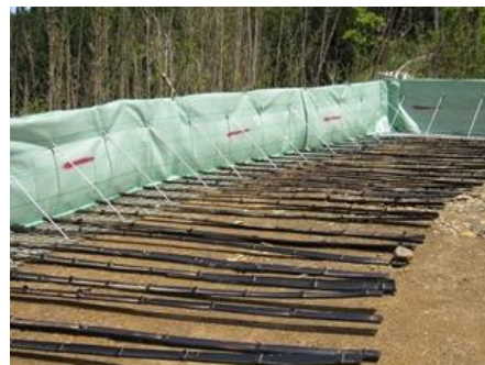
図 バンブーウォールの施工状況
