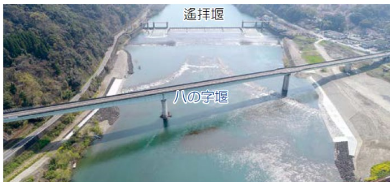
画像 完成した八の字堰
