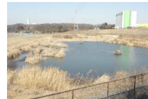
産業団地の敷地内の調整池の環境配慮としてビオトープを整備した。水鳥の生息地として利用されている。
