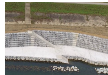
施工事例：兵庫県豊岡市1級河川円山川護岸改修工事
