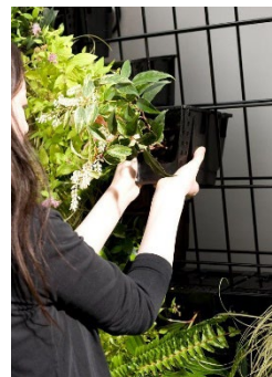
写真 施工の様子
