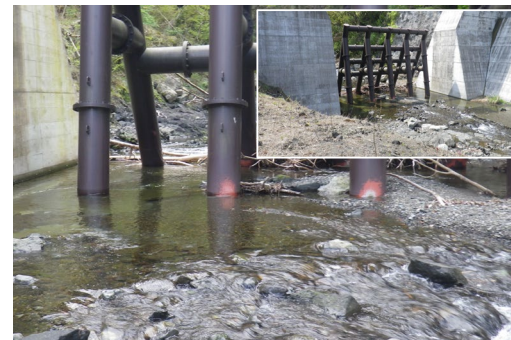
図 富士川水系楮根川での施工事例
