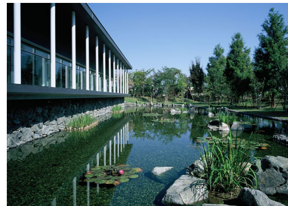
写真 調整池機能のあるビオトープの池
