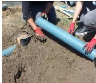
写真 通気透水管の敷設
