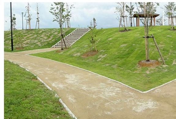
写真 ATTAC工法の施工された園路
