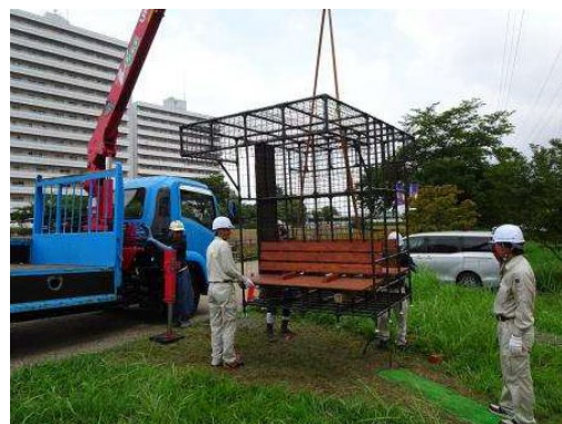
写真 組み立てた状態での搬入の様子
