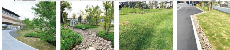
側溝の無い庭と一体となったレインガーデン 庭園の表現にもなる枯山水として 芝生地に 車道や駐車場脇に 事例写真は「大和ハウスグループ みらい価値共創センター」のものです。
