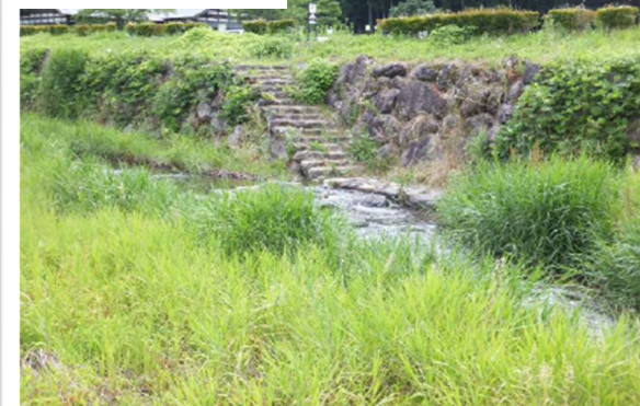
石積の階段整備
