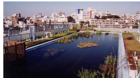
写真 既存の屋上のプールをコンテナを使用したビオトープに改修、非常時は防火用水等に利用
