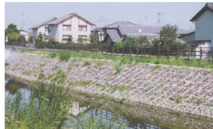
写真 施工イメージ
