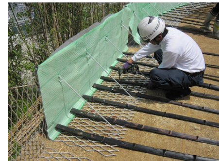
図 バンブーウォールの施工状況
