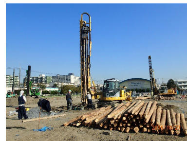
図 LP-LiC工法の施工の様子
