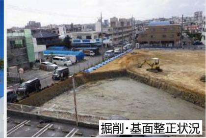
掘削・基面整正状況
