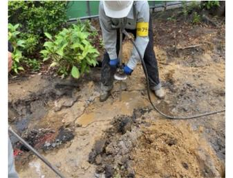
水圧穿孔による空気孔確保、周囲の低木植栽による踏圧防止による
