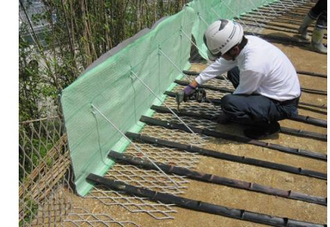
図 バンブーウォールの施工状況
