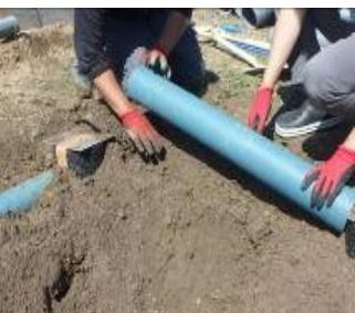
写真 通気透水管の敷設
