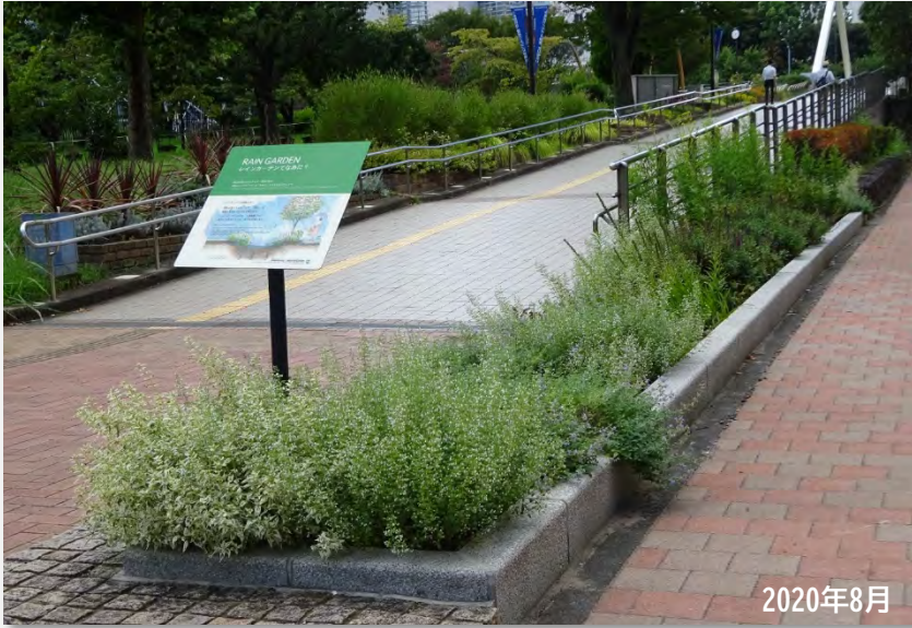
レインガーデンでも処理できない水位に達すると下水に排水。スロープからの雨水をレインガーデンに流入させる構造にして、冠水を防止。
