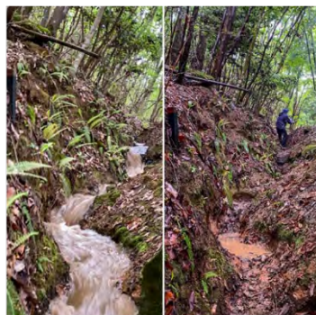
延長2km以上の土掘りの水路の様子
