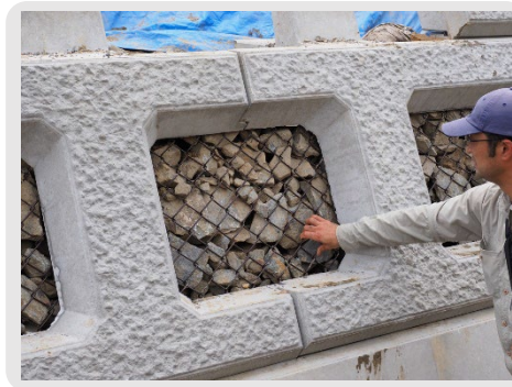
気仙沼市提案による砕石詰めフレーム式護岸の設置
