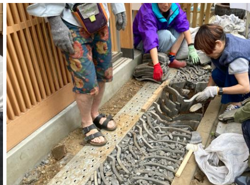
② 皆で穴掘り、瓦加工、設置
