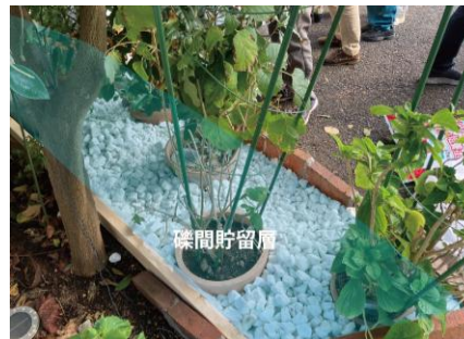
③ 雨どいプランター 上：千葉大学との連携で設計・設置 下：オーバーフローを隣接の礫間貯留層へ
